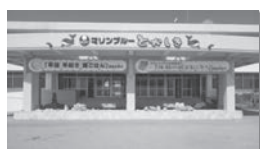
本館《事務室・研修室》
