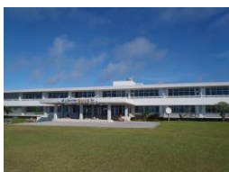
本館〈事務室・研修室〉
