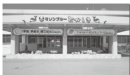
本館《事務室・研修室》
