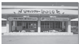
本館《事務室・研修室》
